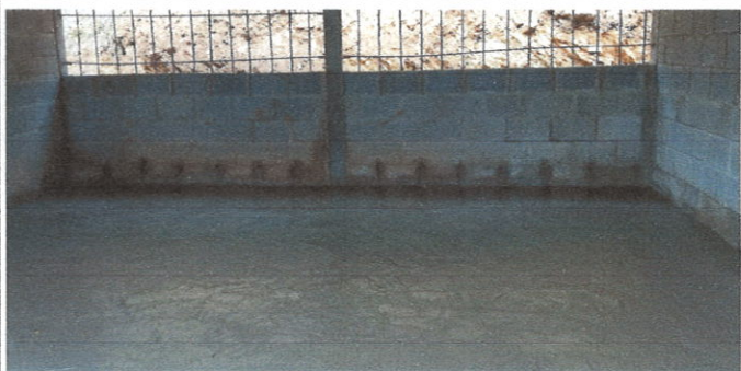
Foto 5: Mejoramiento del piso del aula
