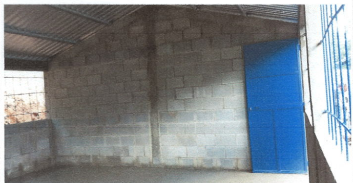
Foto 3: Se mejoro la ventilación del aula así como la iluminación
